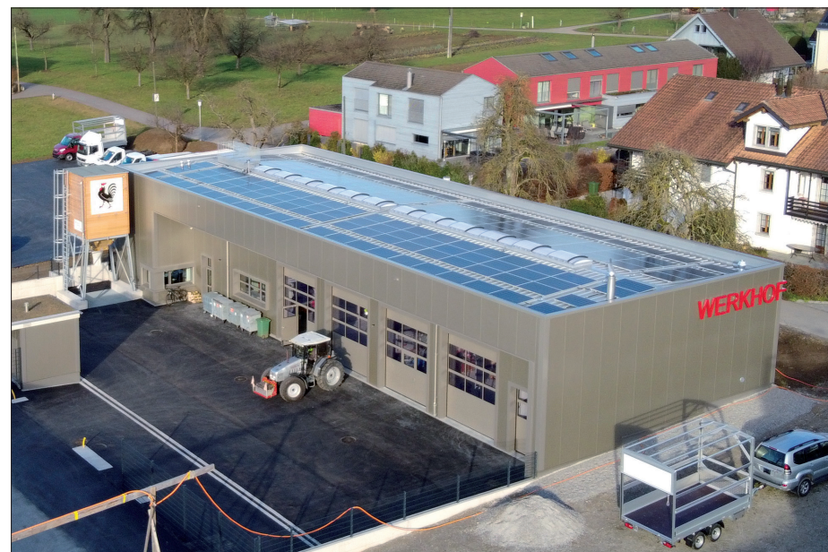
Photovoltaikanlage auf dem Werkhof
