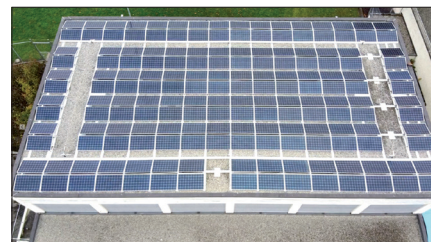
Neue Photovoltaik-Anlage auf dem Turnhallen-Dach
