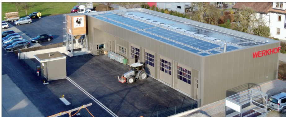
Neuer Werkhof am Hobacher mit Photovoltaik-Anlage auf dem Dach.
